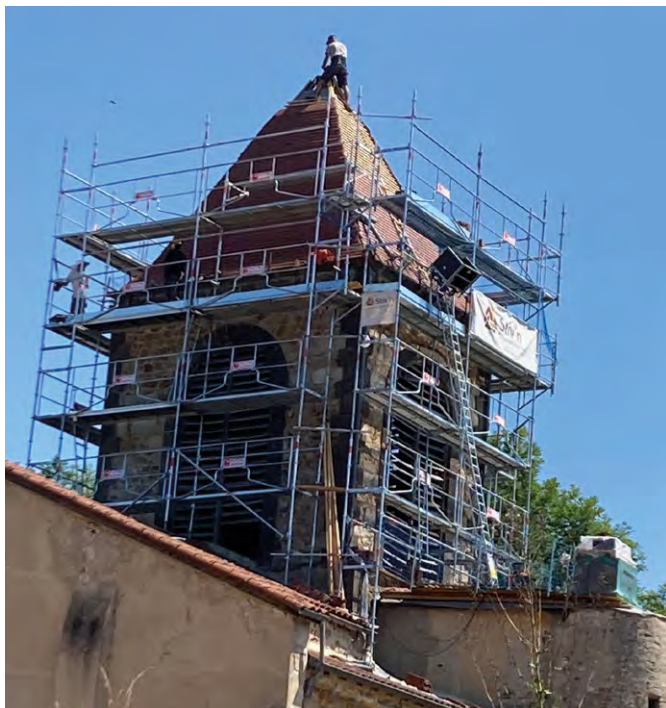
Réfection des toitures du clocher et du transept de l'église Coût : 73 959 € TTC
