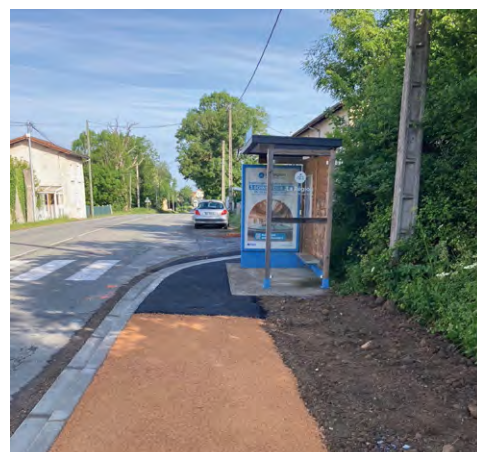
Mise en sécurité traverse et abribus, création d'un trottoir à Chabot
