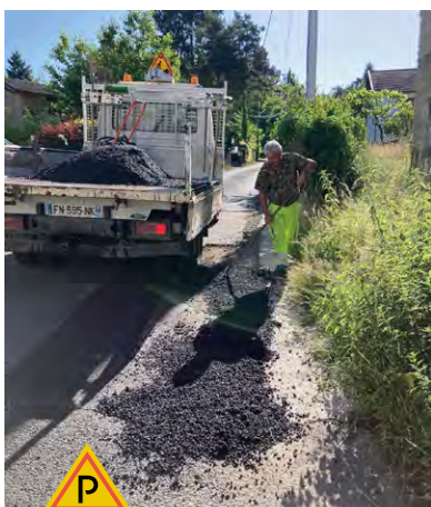
Goudronnage et bouchage des trous Impasse du Petit bois
