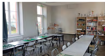
Réfection des installations électriques, plafond et murs doublés en placoplâtre, pose d'un sol PVC, remplacement de la porte et des fenêtres et pose de nouveaux rideaux
