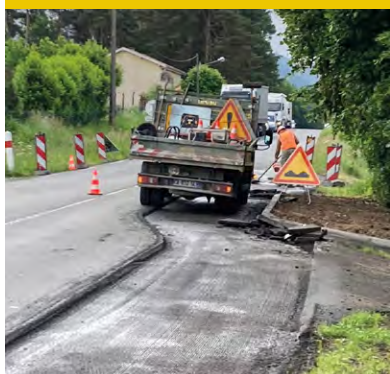
Reprise de la chaussée sur la D906 à l'entrée de Paslières
