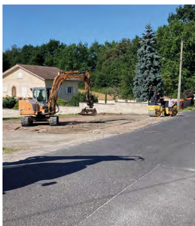
Aménagement du nouveau parking en face de la salle des fêtes
