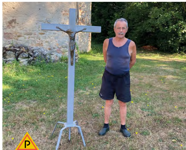
Réparation des abat-sons du clocher de l'église, peinture des portes, entretien de la façade et fabrication d'une nouvelle croix
